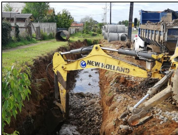
INSTALACIÓN DE TUBOS EN CANAL ALESSANDRI DE HUALPÍN.
