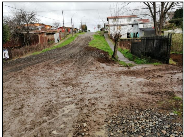
Trabajos en calle 1 Norte
