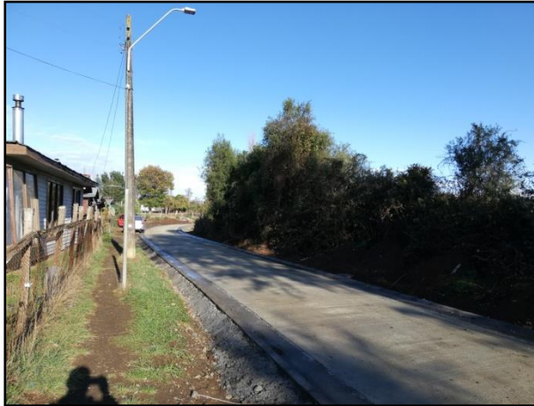
OBRAS DE PAVIMENTACIÓN EN DESARROLLO PASAJE PUYEHUE DE HUALPÍN.
