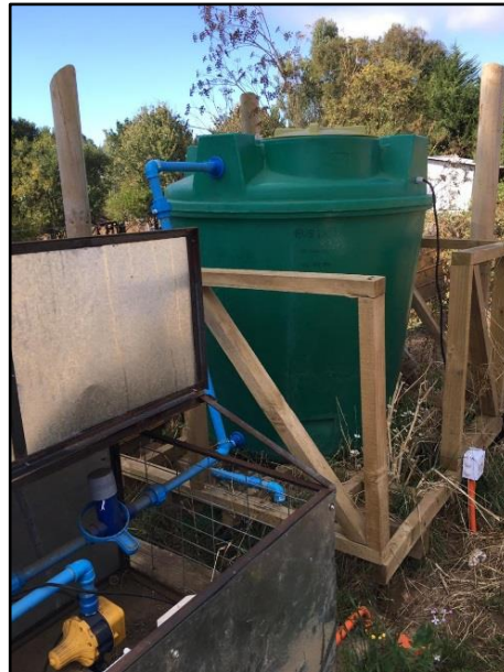
ABASTO DE AGUA POTABLE UBICADO EN SECTOR MOTROLHUE, T. SCHMIDT.
