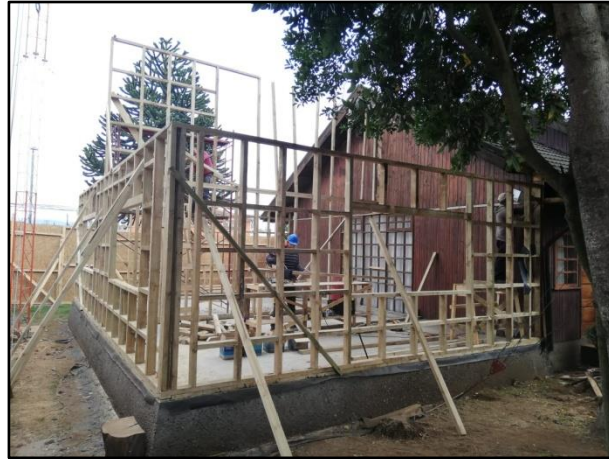
OBRA EN CONSTRUCCIÓN DE AMPLIACIÓN EDIFICIO CONSISTORIAL, T. SCHMIDT.
