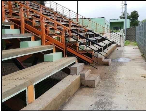
IMAGEN DE BARANDAS Y PELDAÑOS DE TRIBUNA ESTADIO DE HUALPÍN.
