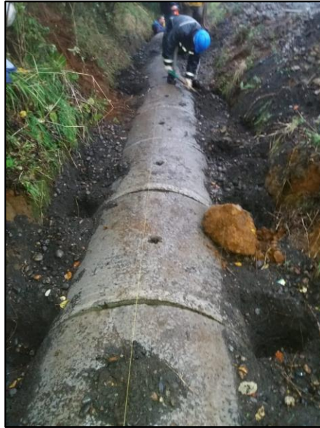
ENTUBAMIENTO COLECTOR AGUAS LLUVIAS CANAL ALESSANDRI DE HUALPÍN.
