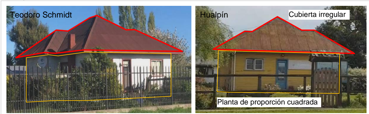
Figura 3. Vivienda Jefe de Estación
