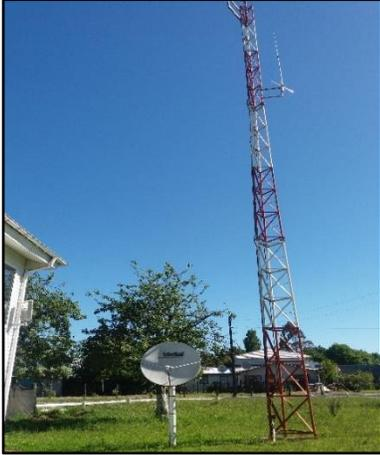
**Antena para radio base y brazo tipo z para soporte antena reten carabineros Barros Arana.**
