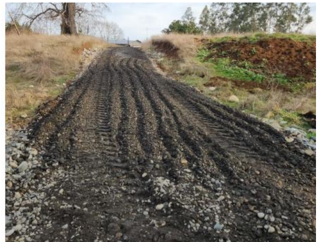
Figura 117. Mejoramiento de camino sector Rehuelhue.
