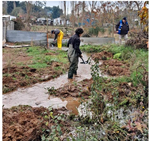
Figura 83. Limpieza de canales – Localidad de Teodoro.
