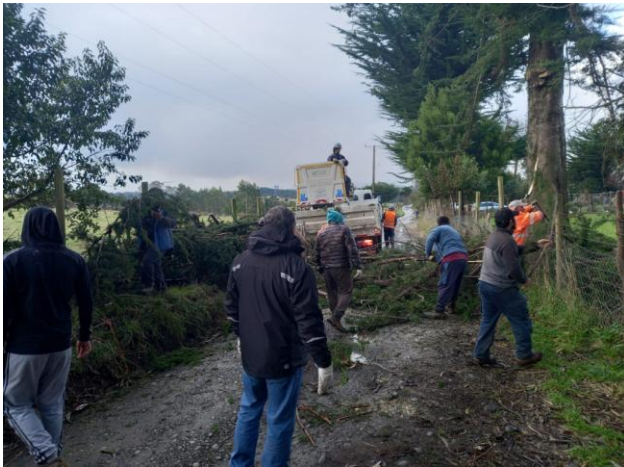
Figura 114. Mejoramiento de camino sector Huate.
