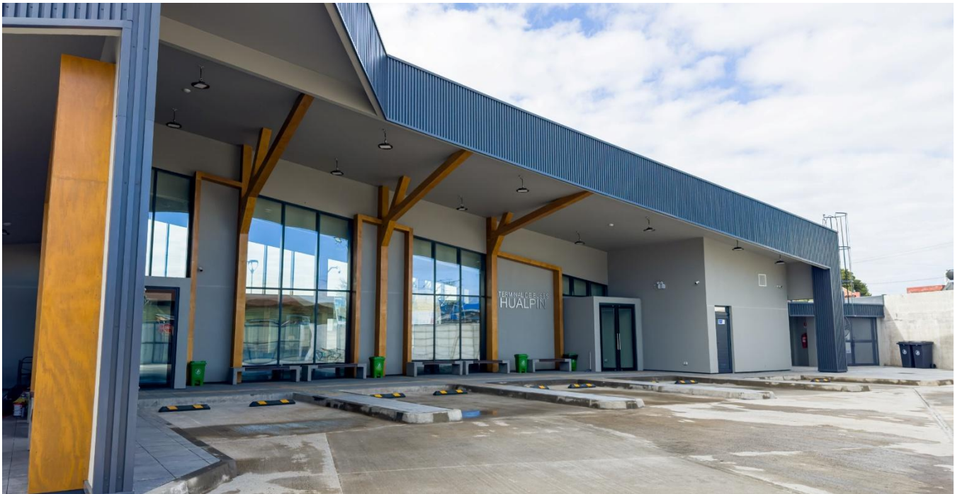
Figura 122. Vista de los andenes del Nuevo Terminal de Buses Hualpin.
