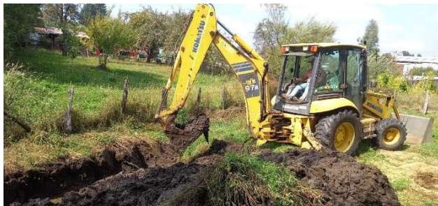
Figura 81. Limpieza de canales, localidad Barros Arana.
