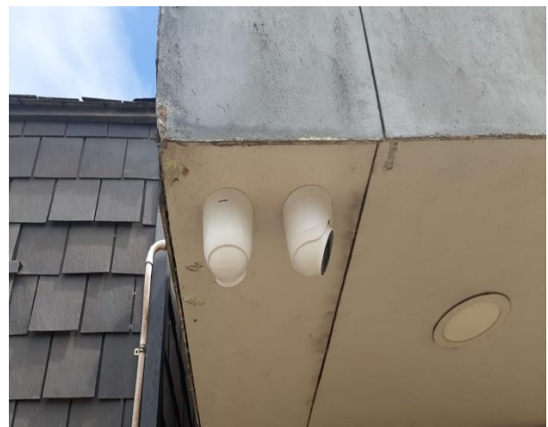
Figura 37. Instalación y habilitación sistema cámaras seguridad centros de salud en DSM T. Schmidt.
