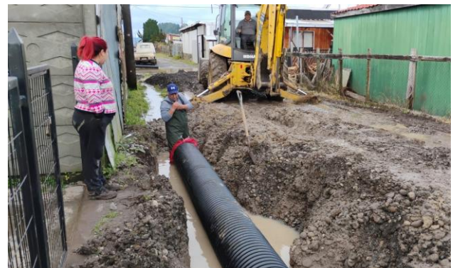
Figura 84. Instalación de tubo HDPE en canal Villa El resplandor – Localidad de Hualpin.
