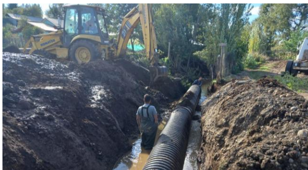
Figura 82. Limpieza e instalación de tubo HDPE de canales.
