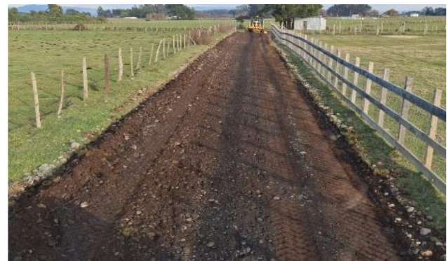
Figura 109. Reperfilado de camino en sector Pidenco
