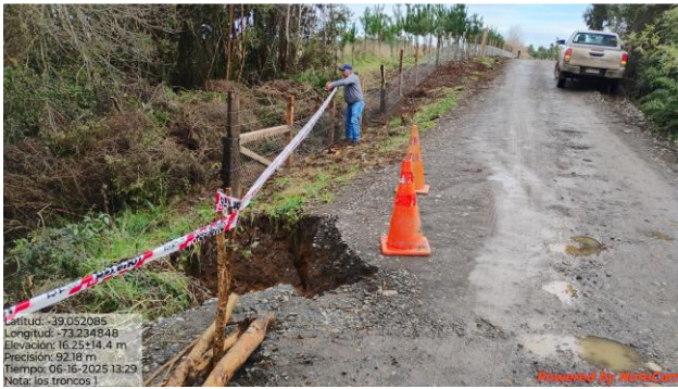
Figura 113. Mejoramiento de camino sector Los Troncos.
