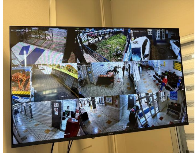
Figura 58. Instalación de cámaras Cesfam T. Schmidt.
