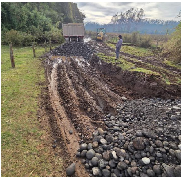
Figura 115. Mejoramiento de camino sector Huilio.
