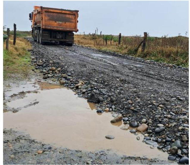
Figura 116. Mejoramiento de camino sector Peleco.
