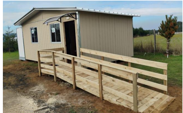
Figura 95. Instalación de vivienda de emergencia sector Pidenco.
