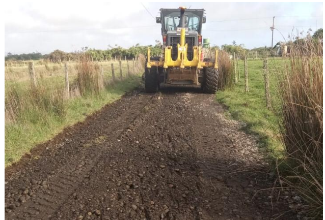
Figura 118. Mejoramiento de camino sector Budi Sur.
