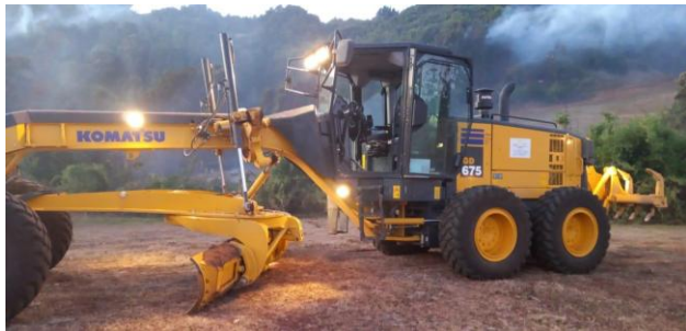
Figura 96. Realización de Cortafuegos sector Peñehue.
