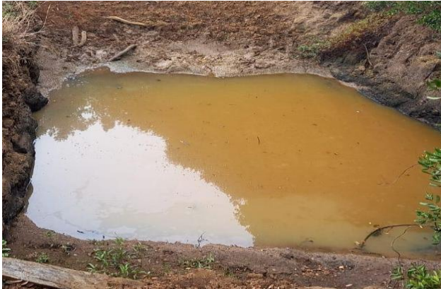
Figura 85. Construcción pozo acumulador sector El Coihue.
